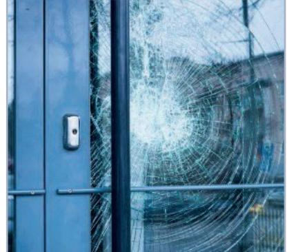
En combinant votre vitrage de contrôle solaire avec une face feuilletée, la sécurité de votre habitation se trouve renforcée. Deux niveaux courants de protection existent : une face feuilletée 44.2 (équivalent à une protection renforcée) et une face feuilletée 44.6 (équivalent à un retardateur d'effraction)
